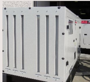
FILTRI MECCANICI PER SABBIA O AMBIENTI MOLTO POLVEROSI MECHANICAL FILTERS FOR DESERT OR VERY DUSTY ENVIRONMENT
